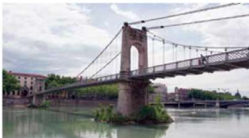
Passerelle du Collège
