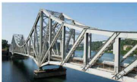
Pont ferroviaire de La Mulatière
